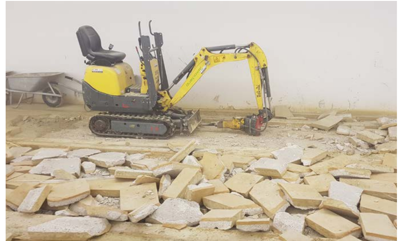
Maschine an: Mit Baggern wurde angerückt, um die Speicherkapazität zu erhöhen.
