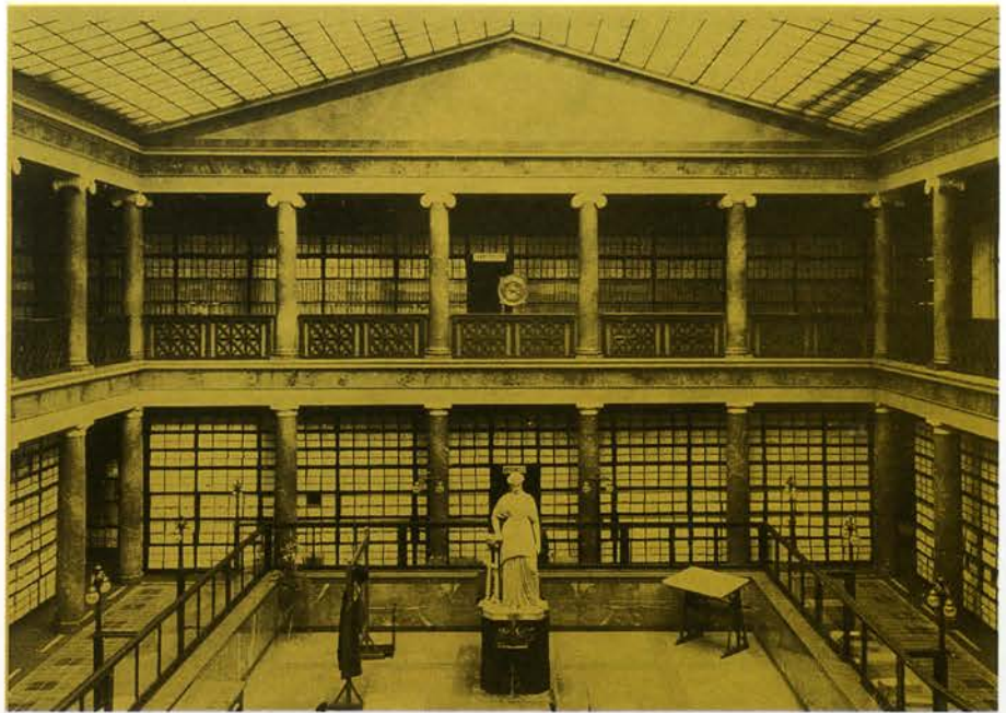
Auch im Kassensaal des ehemaligen Bankgebäudes in der Wallnerstraße 6a wurden nach Übernahme durch das Staatsarchiv Depots für die Lagerung von Archivalien des Allgemeinen Verwaltungsarchivs eingerichtet.
