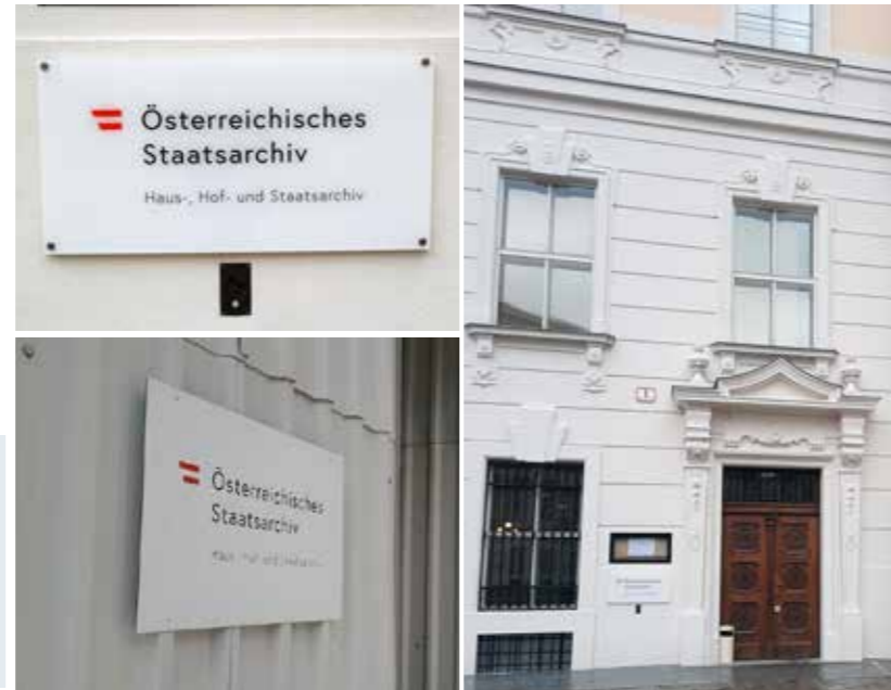
Alles nur Fassade: Das Haus-, Hof- und Staatsarchiv erscheint nicht nur im Inneren in neuem Glanz. Die Fassade blieb ein halbes Jahr hinter einem Bauzaun verborgen.
