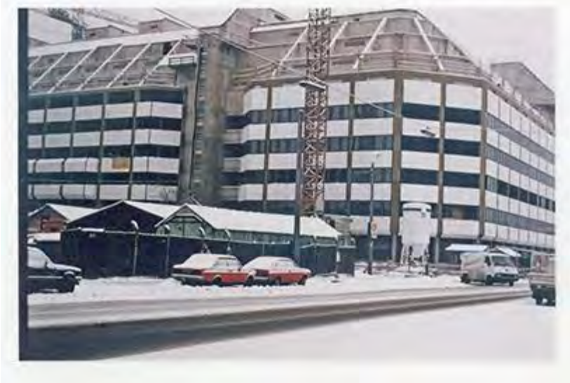
Abbildung 146: Zentralarchivgebäude Erdbergstraße Ecke Nottendorfergasse
