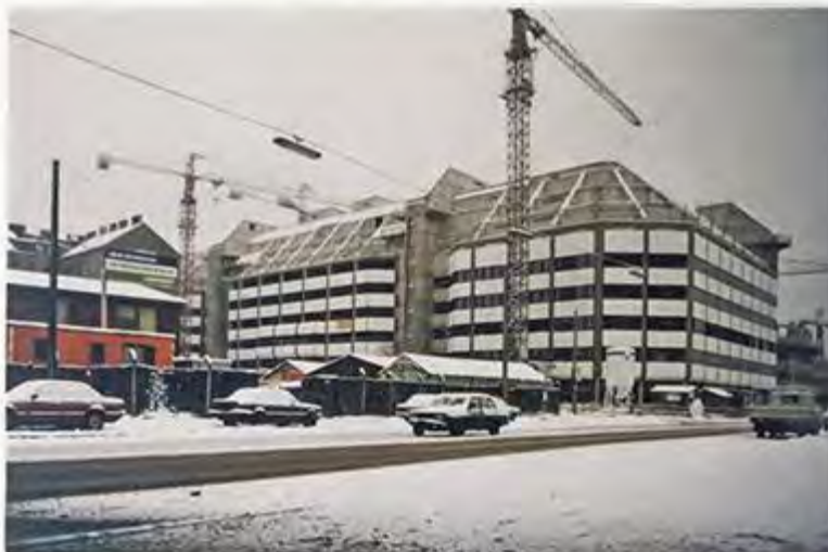
Abbildung 143: Foto Baustelle Zentralarchiv
