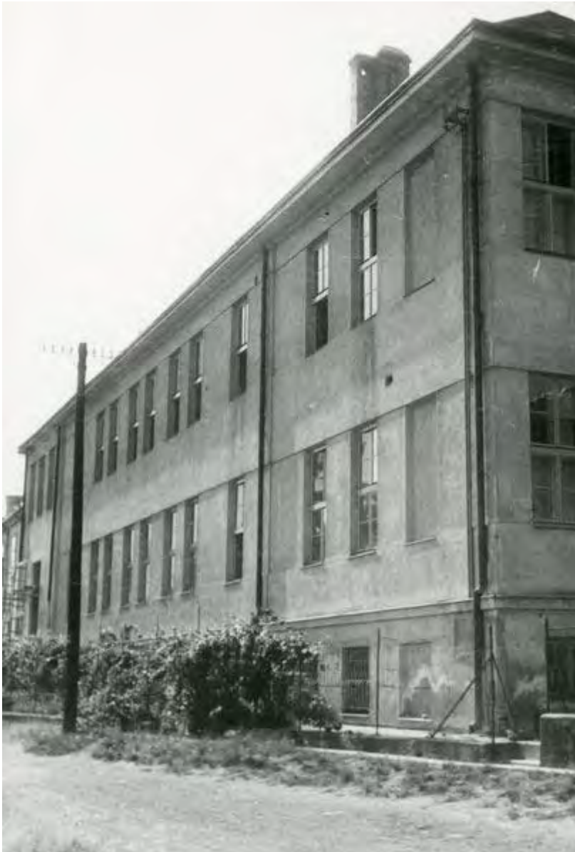
Abbildung 192: Objekt 1 - Blick nach Osten
