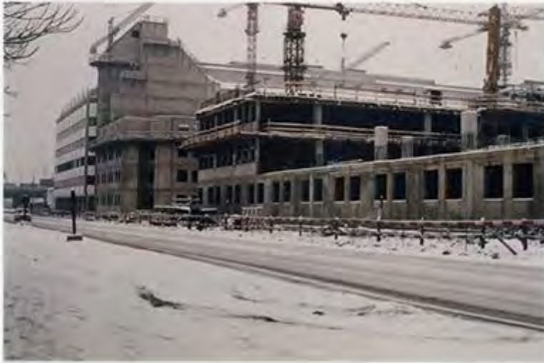
Abbildung 142: Ansicht Baustelle Finanzämter
