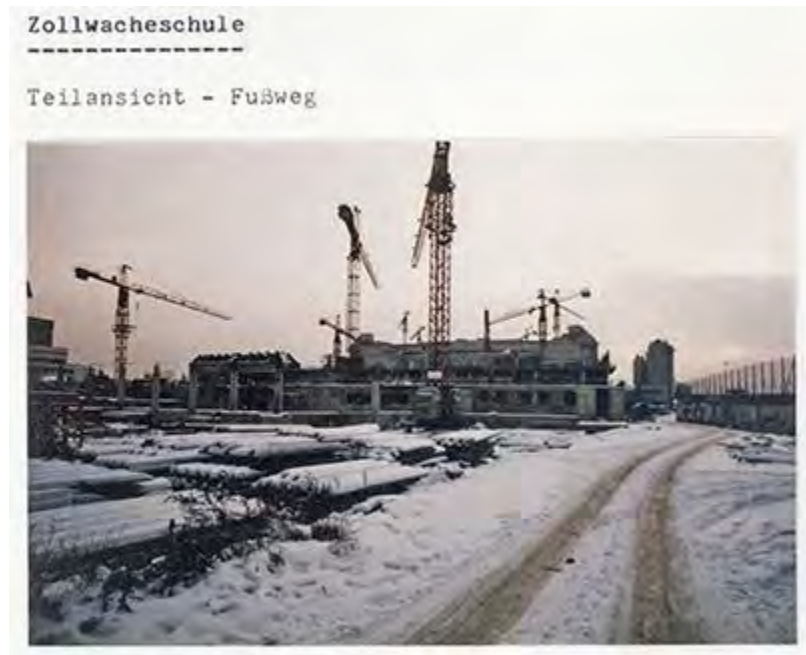
Abbildung 140: Foto Baustelle Zollwacheschule
