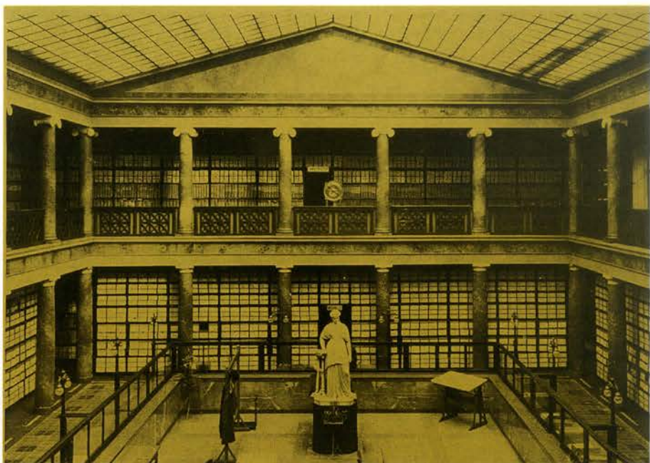
Après la reprise de l'ancien établissement bancaire de la Wallnerstrasse 6a par les Archives nationales, des dépôts pour le stockage des archives des Archives générales de l'administration furent également aménagés dans la salle des guichets.
