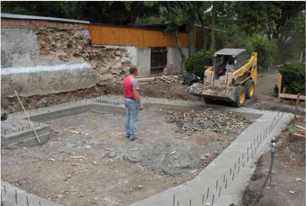
Bild oben: Oktober 2009, Fertigstellung des Fundamentes, links Auflagen für die Stiege. Bild unten: Baubesprechung: Von links nach rechts: Elektriker, Fa. Hein, Ing. Günther Zwölfer, Julius Niederreiter, Bauleiter Ing. Indra der Fa. Fuchs, Baumeister Fuchs.
