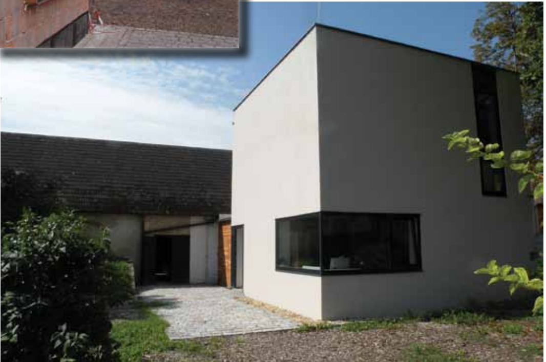
Bild oben: Entwurf Achitekturbüro „GOJA“ vom April 2008 verglichen mit dem Original (Sept. 2010). links: 14 cm Wärmedämmung vorgesehen.
