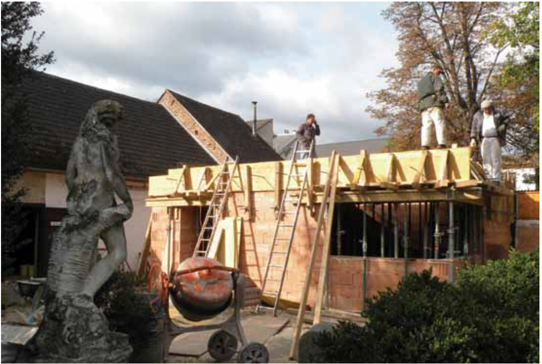
Bild oben: Mitte Oktober 2009, Beginn der Deckenschalung Bild unten: November 2009, kurz vor der Dachgleiche
