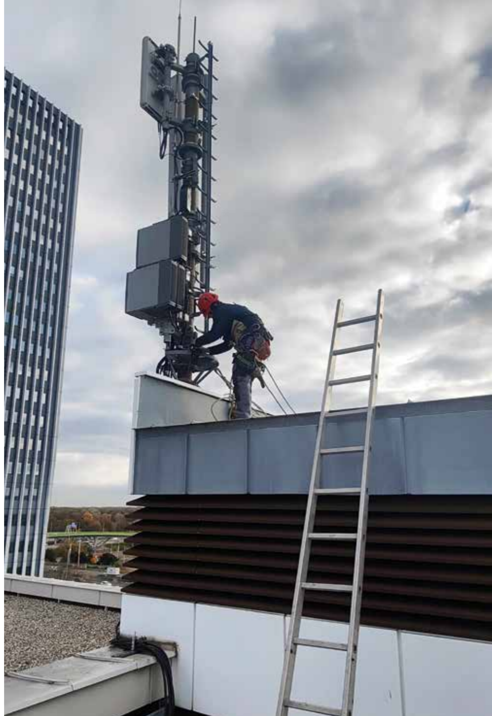
Arbeiten auf dem Dach des Österreichischen Staatsarchivs
