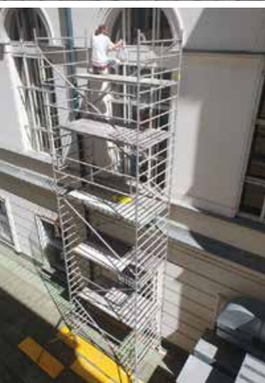
Fenstersanierung von außen...
